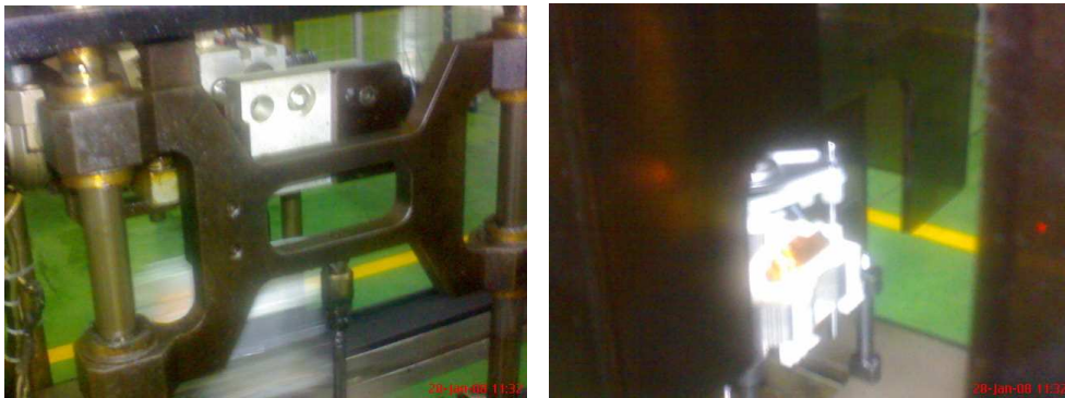
Gambar 4.24. Proses Pengelasan Bearing Plate dengan Stator Pin (O-4).
